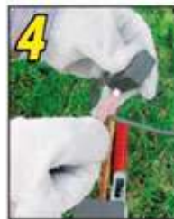
4 Inserte el EZ Lite® del encendedor en el conector.
