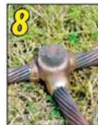
8 Retire el molde de soldadura y limpie antes de tomar la próxima conexión.
