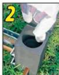
2 Coloque el disco de metal en el fondo del crisol del molde.
