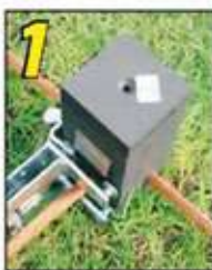
1 Posicione correctamente el molde, conductores y tenaza
