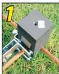
Posicione correctamente el molde, conductores y tenaza
